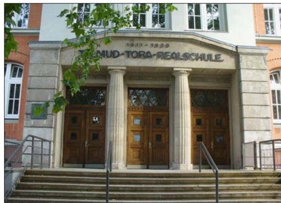
Talmud Tora Schule, heute Gemeindezentrum und Schule
